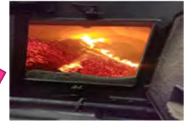
鶏糞の焼却状況
