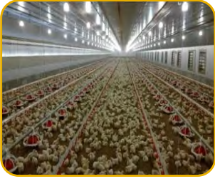
鶏糞温水ボイラーによる床暖房
