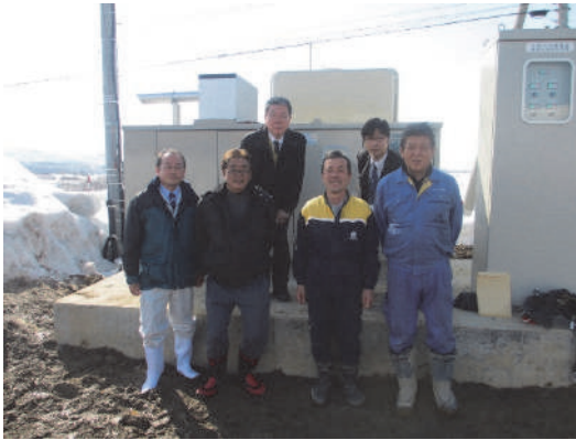
防災用の自家発電機の導入
