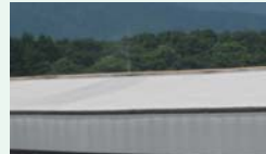
鶏舎内の温度上昇を抑えるために7月～9月は鶏舎の屋根に散水しています。12度くらい違います。
