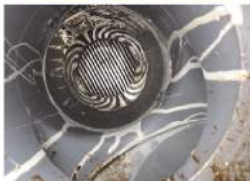
粉塵による熱交換器の閉塞
