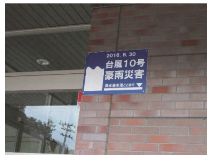
岩泉乳業工場の浸水位置
