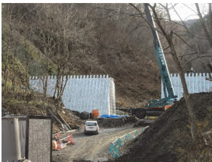
砂防堰堤工事（三田貝地区）
