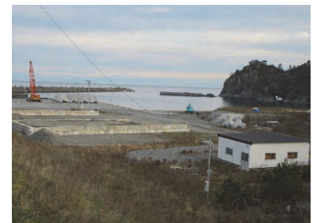
小本海岸の復興状況（小本地区）
