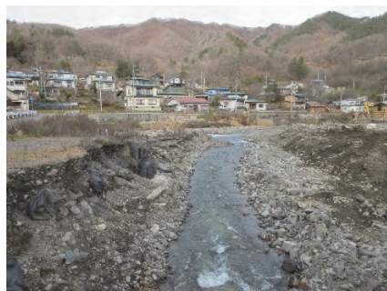
河川改修工事（三田貝川、門地区）
