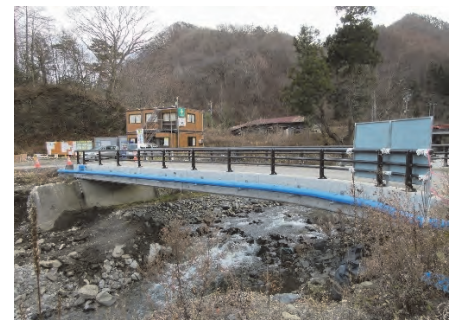
橋梁の復旧（三田貝川、門地区）
