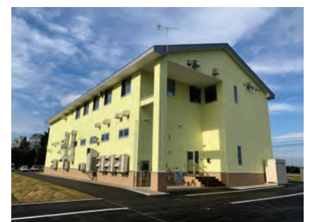
2019年に建設した加工場
