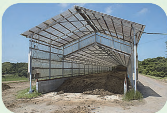
ロータリー式堆肥発酵施設
